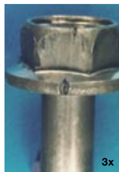
图7a: 裂缝导致的碳钢螺栓头裂口
